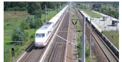
Schnellfahrstrecke Berlin--Hannover. Nach nur 13 Jahren sind 2011 umfangreiche Sanierungsarbeiten erforderlich. Weil das Gleis der alten Lehrter Bahn (rechts) aus Kostengründen nur teilweise elektrifiziert wurde, kann es jetzt nicht als Ausweichgleis für die ICE-Züge genutzt werden. (Foto: Christian Schultz)
