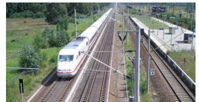
Schnellfahrstrecke Berlin--Hannover. Nach nur 13 Jahren sind 2011 umfangreiche Sanierungsarbeiten erforderlich. Weil das Gleis der alten Lehrter Bahn (rechts) aus Kostengründen nur teilweise elektrifiziert wurde, kann es jetzt nicht als Ausweichgleis für die ICE-Züge genutzt werden. (Foto: Christian Schultz)
