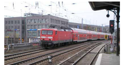
Berlin-Köpenick. Hier soll für den RE1 in den Jahren 2012/13 ein Regionalbahnhof gebaut werden. Da der Bund die Finanzierung inzwischen verweigert, muss das Land Berlin einspringen, was aufgrund der einbehaltenen S-Bahn-Gelder möglich ist. Siehe auch Foto auf Seite 7. (Foto: Christian Schultz)
