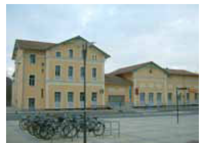
Bahnhof Strausberg, Stadtseite, nach der Sanierung. (Foto: Frank Lammers (20.11.2010))
