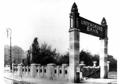
Ein Markenzeichen der Schöneberger U-Bahn waren die pompösen Portale wie hier am Zugang zum Bahnhof Stadtpark (heute Rathaus Schöneberg). (Foto um 1910): Paul Wittig, Architektur der Hoch- und Untergrundbahn in Berlin, Berlin 1922)
