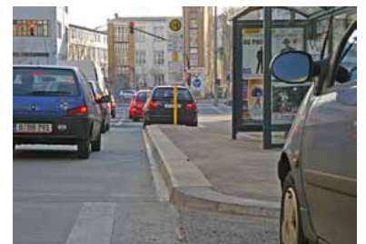
Fahrgastfreundlich: Neugebautes Bus-Kap mit »Kasseler Bord« in Lichtenberg am U-Bf Magdalenenstraße. (Foto: Florian Müller)
