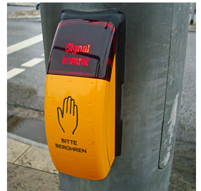
Unnötiges Erschwernis für die vielen Umsteiger Bahn/Bus am Hauptbahnhof: Eine Anforderungssampel mit langen Rotphasen für die Fußgänger beim Überqueren der Invalidenstraße. (Foto: Florian Müller)
