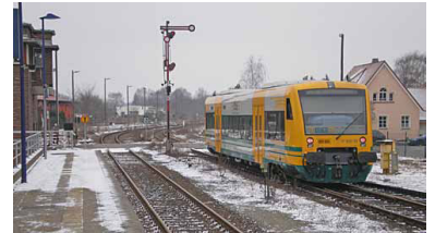
Vernachlässigte Infrastruktur, zum Beispiel auf der Strecke Berlin-Schöneeweide-Beeskow (Foto)-Frankfurt (Oder). Der VBB errechnete in seiner »Qualitätsanalyse Netzzustand 2009« für die hier verkehrende Linie OE 36 einen Zeitverlust durch Geschwindigkeitseinbrüche für Hin- und Rückfahrt von mehr als 30 Minuten! (Foto: Christian Schultz)
