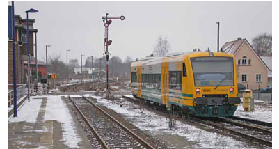
Vernachlässigte Infrastruktur, zum Beispiel auf der Strecke Berlin-Schöneeweide-Beeskow (Foto)-Frankfurt (Oder). Der VBB errechnete in seiner »Qualitätsanalyse Netzzustand 2009« für die hier verkehrende Linie OE 36 einen Zeitverlust durch Geschwindigkeitseinbrüche für Hin- und Rückfahrt von mehr als 30 Minuten! (Foto: Christian Schultz)
