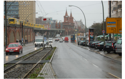
Ein Provisorium sollte die Endhaltestelle am U-Bahnhof Warschauer Straße sein, als sie im Mai 2000 in Betrieb ging. Doch wann die geplante Verlängerung Richtung Schlesisches Tor und Hermannplatz erfolgt, ist inzwischen völlig offen.
