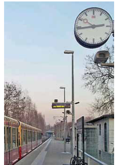
S-Bahnhof Spindlersfeld - dreifacher Mangel bei der Fahrgastinformation: Die Uhr geht seit Monaten nicht mehr, der Lautsprecher wird nicht genutzt und der dynamische Schriftanzeiger zeigt die Uhrzeit an, obwohl der hier stehende Zug wegen der Personalengpässe wieder mal nur bis Schöneweide statt Hermannstraße fährt. (Foto: Patrick Schardien)
