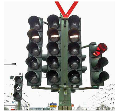
Lichtsignalanlage für Straßenbahnen Landsberger Allee Ecke Petersburger Straße. Der waagerechte Balken bedeutet »Halt« - ein Signaltyp, das die Straßenbahn allzu oft sieht. (Foto: Marc Heller)
