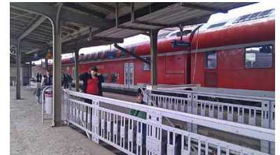
Bahnhof Prenzlau mit RE 3 kurz vor Beginn der Bauarbeiten. Der RE 3 verbindet die Kreisstadt der Uckermark mit Berlin und Stralsund. (Foto: Florian Müller)
