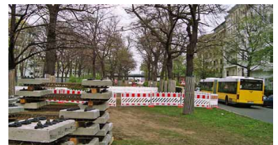
Im April 2012 begannen die Gleisarbeiten in der Straße Alt-Moabit. (Fotos: Florian Müller)
