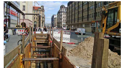
Seit einem Jahr laufen die Leitungsarbeiten in der Invalidenstraße.
