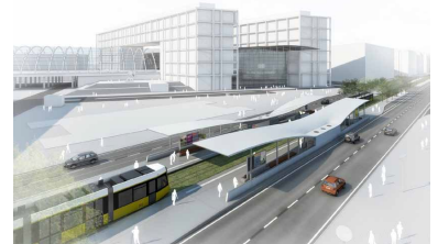
Künftige Straßenbahnhaltestelle am Berliner Hauptbahnhof. An diesen Bahnsteigen mit den markant geschwungenen Dächern sollen ab 2014, acht Jahre später als ursprünglich geplant, die Straßenbahnzüge vom Nordbahnhof ankommen. (Simulation: Gruber + Popp)
