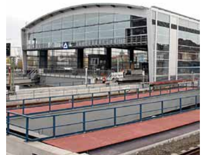
Die neue Ringbahnhalle Ostkreuz während der Ostringssperrung.
