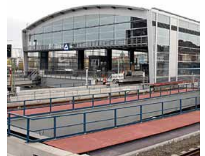
Die neue Ringbahnhalle Ostkreuz während der Ostringssperrung.
