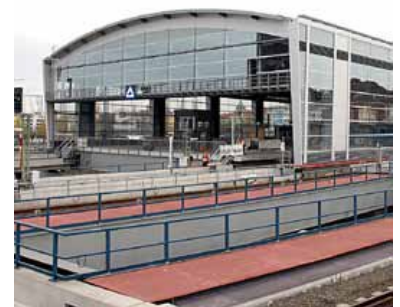
Die neue Ringbahnhalle Ostkreuz während der Ostringssperrung.
