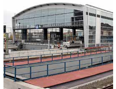
Die neue Ringbahnhalle Ostkreuz während der Ostringssperrung.
