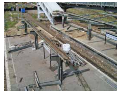
Am Bahnhof Warschauer Straße hat im April der Abbruch der Dächer und Bahnsteige begonnen. (Fotos: Florian Müller)
