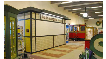
Baustelle S-Bahn-Museum. Hier entsteht ein Dienstraum im Stil der 30er Jahre. (Fotos: Udo Dittfurth)
