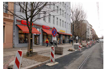
Durch den Umbau der Kastanienallee werden Straßenbahn und Fahrradverkehr getrennt. Das erhöht die Verkehrssicherheit. Bisher mussten die Radfahrer zwischen den Straßenbahngleisen fahren, künftig können sie rechts daneben fahren. (Foto: Marc Heller (12/2011))
