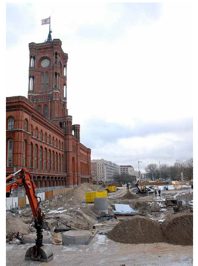
Die Baustelle des teuersten ÖPNV-Projekts Berlins liegt direkt vor dem Roten Rathaus: Die U 5-Verlängerung. Auch dieses Projekt ist zwischen Berliner SPD und CDU unstrittig. (Foto: Marc Heller)
