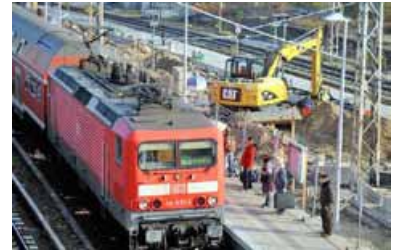
Halt nur in eine Richtung: Die Züge in Richtung Eberswalde fahren immer noch nicht. Die Deutsche Bahn verschob die Fertigstellung um zwei Wochen. (Foto: U. Winkler)
