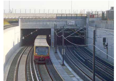
Zwischenbahnhof Waßmannsdorf mit den Treppenhäusern und Vorplatz (Vorfahrt, Buswartehäuschen, P+R-Platz, Fahrradbügel) (Foto: Florian Müller)
