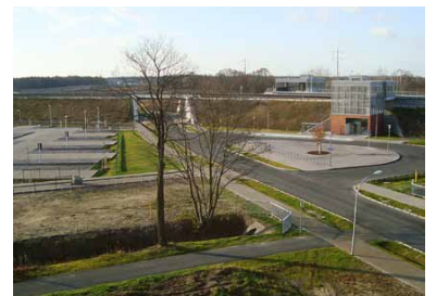
Der Tunnelmund bei Selchow zum unterirdischen Abschnitt unter dem Flughafengelände. Auf den Gleisen rechts wird künftig unter anderem der Flughafenexpress nach Berlin Hbf über Südkreuz verkehren. Der Tunnel unter dem Flughafen ist 3000 Meter lang. (Foto: Florian Müller)
