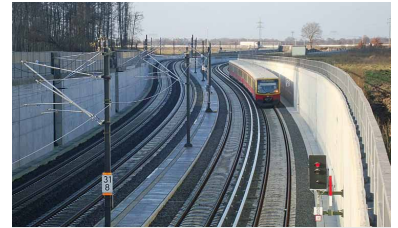
Testzug als Linksfahrt Richtung BER. Links die Fern/Regiogleise (Foto: Florian Müller)
