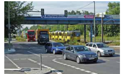
An der Kreuzung Rhinstraße/Pyramidenring/Zufahrt IKEA wurde eine neue Lichtsignalanlage installiert. Die Straßenbahnzüge der hier verkehrenden Linien M 17 und 27 haben jedoch keine Vorrangschaltung und werden in beiden Richtungen regelmäßig ausgebremst. In Fahrtrichtung Norden wird dadurch fast immer die Grünphase an der gleich anschließenden Kreuzung Rhinstraße/Landsberger Allee verpasst, so dass eine Fahrzeitverlängerung von 2 Minuten entsteht. (Foto: Matthias Horth)
