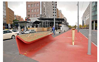
Der Bau der Straßenbahnverlängerung vom Alexanderplatz zum Kulturforum ist Bestandteil der Maßnahmen im jetzt fortgeschriebenen Stadtentwicklungsplan Verkehr. Umso verständlicher ist, dass der Senat auf der künftigen Straßenbahntrasse in der Potsdamer Straße 2010 den sogenannten Boulevard der Stars für 1,6 Mio Euro gebaut hat. (Foto: Marc Heller)
