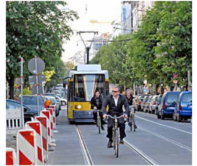
Noch müssen die Radfahrer auf der Kastanienallee zwischen den Straßenbahnschienen fahren. Durch den Umbau sollen sie einen eigenen Fahrradstreifen erhalten. (Foto: Marc Heller)
