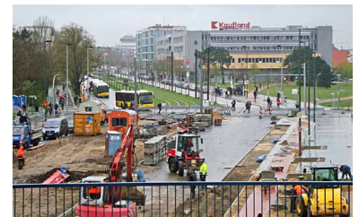
Blick vom S-Bahnsteig Adlershof auf die Rudower Chaussee mit der Baustelle der Straßenbahntrasse auf dem Mittelstreifen. Im Hintergrund das bereits fertiggestellte Rasengleis. (Foto: Florian Müller (14. April 2011))
