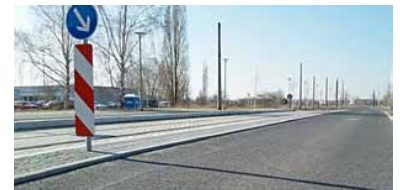
Karl-Ziegler-Straße - vorläufige Endstelle ab September 2011, ausgeführt als Kap-Haltestelle. Die IGEB fordert den schnellen Weiterbau über den Groß-Berliner Damm zum Bahnhof Schöneweide. (Foto: Jens Ullrich)
