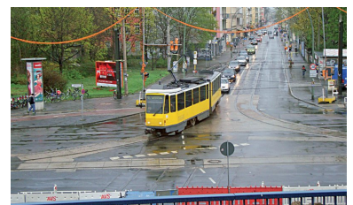
Bestehendes temporäres Wende-Gleisdreieck auf dem Adlergestell für SL 60 und 61. (Foto: Florian Müller)
