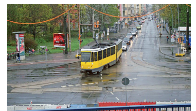
Bestehendes temporäres Wende-Gleisdreieck auf dem Adlergestell für SL 60 und 61. (Foto: Florian Müller)
