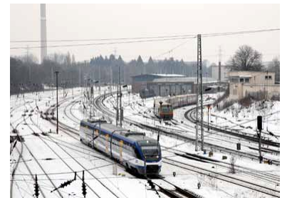
S-Bahn-Betriebswerkstatt Friedrichsfelde. Im Januar 2010 wurde sie zunächst provisorisch in Betrieb genommen. Jetzt wird sie ausgebaut und bleibt mindestens bis 2017 erhalten. (Foto: Marc Heller)
