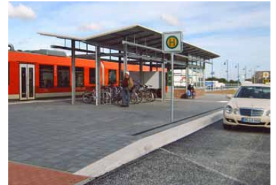
Bewohner und Urlauber können sich freuen: Mit dem Bahnhofsneubau hat Burg auf Fehmarn nach 27 Jahren endlich wieder eine direkte Anbindung ans Schienennetz. (Foto: Wolf-Rüdiger Grätz)
