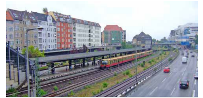
S-Bahnhof Messe Nord, davor die Gleise des Berliner Innenrings, der hier zweigleisig und elektrifiziert ist, derzeit aber nur von Güterzügen befahren wird. An dieser Stelle könnte der Messebahnhof für Regionalzüge Potsdam Hbf--Berlin Messe--Berlin Hbf--BBI gebaut werden. (Foto: Frank Böhnke)
