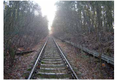
Das Gleis und der Kabelkanal am Klinikum wurden vor rund 10 Jahren erneuert - und seitdem nie benutzt. Damals hoffte man noch auf die Wiederinbetriebnahme nach Beeskow, bis die Arbeiten abgebrochen wurden. (Foto: Florian Müller)
