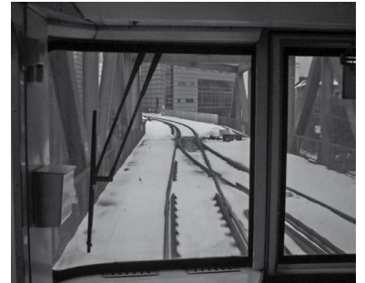
Die Bauweiche auf der Landwehrkanalbrücke der U1 sollte kurz vor Weihnachten ausgebaut werden. Damit wäre die zweigleisige Befahrbarkeit zwischen Möckernbrücke und Gleisdreieck wieder hergestellt gewesen und die Baustelle beendet. Aber durch Frost verzögerte sich der Ausbau um 10 Wochen. Entsprechend verlängerte sich die U1-Unterbrechung. (Foto: Florian Müller)
