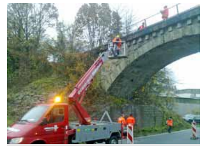
Brückenprüfung durch die DRE an der Strecke Passau--Hauzenberg. (Foto: Heidi Bauer)
