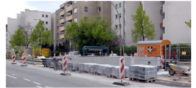
Bau des 2. Ausgangs am U-Bahnhof Rudow. »Damit verfügen dann alle 170 U-Bahnhöfe über einen 2. Ausgang«, schrieb die BVG. Doch wo sind die 2. Ausgänge bei den Stationen Paradestraße, Jungfernheide, Zitadelle und Lindauer Allee? (Foto: Marc Heller)
