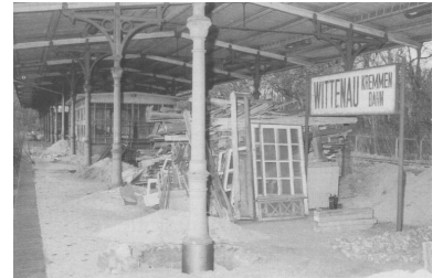
Baustelle Kremmener Bahn im Januar 1995. Ob der zuletzt angestrebte Wiederinbetriebnahmetermin Ende Mai 1995 geschafft wird, ist noch nicht ganz sicher. Doch viel beunruhigender ist eine andere Meldung: Die Planungen für die Weiterführung der von Tegel nach Hennigsdorf sind gestoppt, weil die auf der Kremmener Bahn zum wiederholten Male grundsätzlich in Frage gestellt wird. (Foto: Bodo Schulz)
