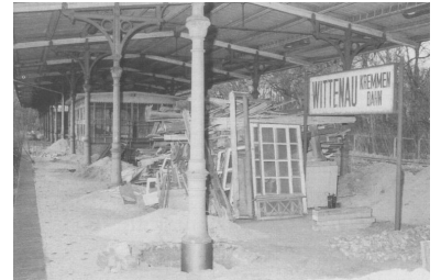
Baustelle Kremmener Bahn im Januar 1995. Ob der zuletzt angestrebte Wiederinbetriebnahmetermine Ende Mai 1995 geschafft wird, ist noch nicht ganz sicher. Doch viel beunruhigender ist eine andere Meldung: Die Planungen für die Weiterführung der von Tegel nach Hennigsdorf sind gestoppt, weil die auf der Kremmener Bahn zum wiederholten Male grundsätzlich in Frage gestellt wird. (Foto: Bodo Schulz)
