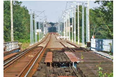
Die Weißbrücke an der Grenze Deutschland/Polen bei Horka im Jahr 2008. Auf polnischer Seite (Hintergrund) ist die Strecke bereits zweigleisig und elektrifiziert. In Deutschland geht es nur eingleisig mit Diesel weiter. Nun will auch Deutschland seinen Teil ausbauen. (Foto: IGEB)
