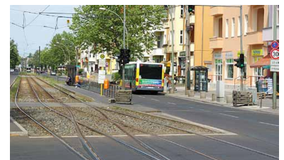
Dieser Gleiswechsel wurde 2008 von der BVG zum Wenden vor den Brücken am Bahnhof Karlshorst eingebaut. Hier kehren jetzt die Linien E und 37. (Foto: Michael Dittrich)
