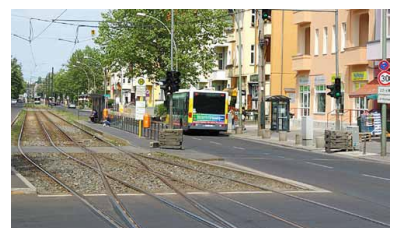
Dieser Gleiswechsel wurde 2008 von der BVG zum Wenden vor den Brücken am Bahnhof Karlshorst eingebaut. Hier kehren jetzt die Linien E und 37. (Foto: Michael Dittrich)
