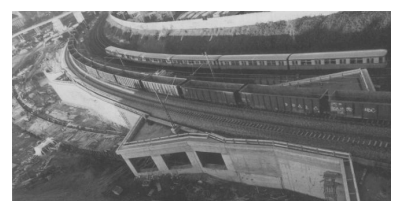
16. Januar 1995. Seit diesem Tag können wieder Fernzüge zwischen Pankow und Greifswalder Straße verkehren. Das Foto zeigt das neue Überführungsbauwerk der Fernbahn über die S-Bahn. Links im Bild sind die Aus- und Einfahrt der S-Bahn-Untertführung für die Züge von Schönhauser Allee nach Bornholmer Straße zu erkennen, die jetzt nach nordöstlich der
