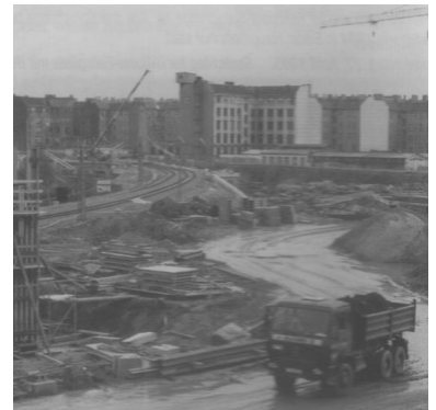
Baustelle Nordkreuz. Beide Fotos zeigen die S- und Fernbahngleise von Pankow (Stettiner Bahn) zur Greifswalder Straße (Nordring), oben im November 1992 vor dem Abbau der Fernbahngleise, hier im November 1994 nach deren Wiederaufbau. Bisher lagen sie auf einem Damm, jetzt führen sie über ein großes Brückenbauwerk (Foto: Bodo Schulz)
