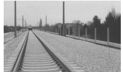
Die Hamburger Bahn in Staaken in Höhe Finkenkruger Weg Anfang März 1995. Die Dammkronen sind mit Schotter versehen, und das nördliche Regional- und Ferngleis ist bereits bis zur Gartenstadt verlegt. Rechts im Bild ist die im Aufbau befindliche Schallschutzwand an der Südseite der Trasse zur Gartenstadt Staaken hin zu erkennen. Links, an der Nordseite der Trasse zu den Häusern am Seegefälder Weg hin, wird entgegen der Darstellung in den ausgelegten Plänen keine Schallschutzwand errichtet. Um diese einseitigen Schallschutzmaßnahmen gibt es nun Ärger. Die betroffenen Anwohner und das Bezirksamt fühlen sich getäuscht und protestieren. Einige Betroffene bereiten Klagen vor. So schafft sich die Bahn unnötigerweise Gegner. (Foto: Heinz-Peter Schwarz)
