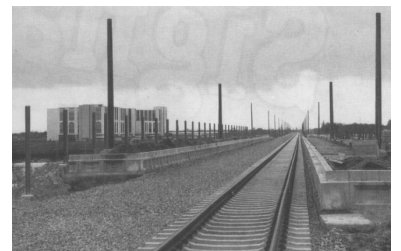
Der neue Haltepunkt Albrechtshof auf der Hamburger Bahn Anfang März 1995, Blickrichtung Westen (Falkensee). Die beiden Seitenbahnsteige werden nur über Zugänge am westlichen (hinteren) Ende erschlossen, wodurch bezogen auf den Siedlungsschwerpunkt unnötig weite Fußwege zum Bahnhof zurückzulegen sind. Das große Gebäude südlich der Strecke (links im Bild) ist das neue Fabrikgebäude der Fa. Herlitz. (Foto: Heinz-Peter Schwarz)
