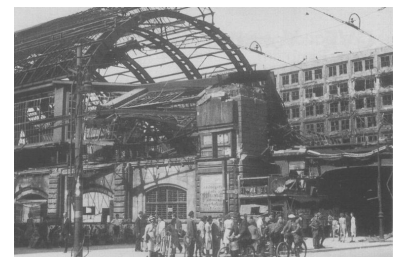
Nach den Zerstörungen im Krieg (oben Bf Alexanderplatz) mußte die S-Bahn nach Kriegsende weitere Verluste durch Demontagen hinnehmen, so z.B. auf der Strecke nach Erkner 1947 (unten). (Foto: LaBi)
