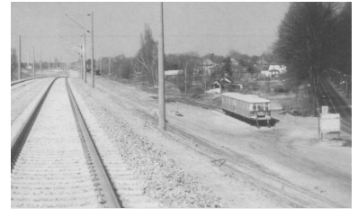
Blick nach Westen auf die Hamburger Bahn, etwa 1 km östlich des Bahnhofes Falkensee. Die Arbeiten an dem Gleispaar für die Fern- und Regionalzüge erfolgten im Rahmen des Verkehrsprojektes Deutsche Einheit Nr. 2 und sind fast abgeschlossen. Ende Mai konnte der Abschnitt Falkensee Spandau zunächst eingleisig in Betrieb genommen werden. Demgegenüber ist die Wiederinbetriebnahme der S-Bahn noch immer ungewiß. Der rechts im Bild zu erkennende, zum umgebaute (Buletten- Susi) veranschaulicht die Situation: Die Politiker haben die S-Bahn vorläufig auf ein Abstellgleis rangiert. Selbst der Damm ist hier, westlich der Brücke über die geplante Umgehungsstraße von Falkensee, nur für zwei Gleise angelegt worden. (Foto: Heinz-Peter Schwarz)
