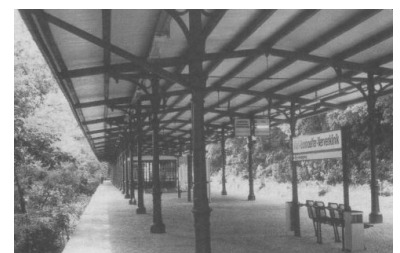
S-Bahnhof Karl-Bonhoeffer-Nervenklinik, ehemals Wittenau (Kremmener Bahn), auf der eingleisig wiederhergestellten Strecke zwischen Schönholz und Tegel. Die Schönheit dieses für die Berliner S-Bahn typischen Bahnsteigdaches werden die Fahrgäste wohl noch viele Jahre genießen können, denn es gibt wichtigere Projekte als die Verschiebung des S-Bahnhofs zum nahegelegenen gleichnamigen U-Bahnhof auf der U8-Nord. (Foto: I. Schmidt)
