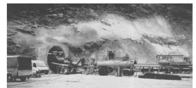
Vortrieb eines Sondierstollens am Gotthard. (Foto: SBB)
