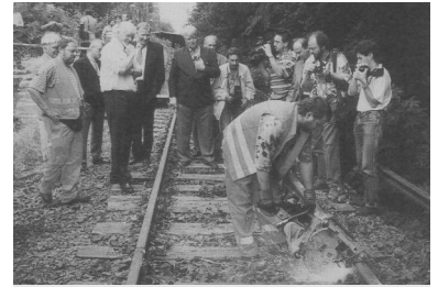
Am 14. August war am S-Bf Schulzendorf der große Spatenstich mit viel Prominenz, damit 1996 endlich wieder S-Bahn-Züge nach Heiligensee und Hennigsdorf fahren können. Alle hatten zugestimmt, die Länder Berlin und Brandenburg ebenso wie die DB AG und natürlich die S-Bahn GmbH, und Prof. Mängel von der Planungsgesellschaft Bahnbau Deutsche Einheit versprach eine zügige Realisierung: Am Nikolaustag 1996 können sie bis Hennigsdorf fahren! Doch dann holte das Eisenbahn-Bundesamt die Rute aus dem Sack und alle bekamen Prügel, weil das EBA nicht ordnungsgemäß einbezogen worden war. (Foto: Marc Heller)
