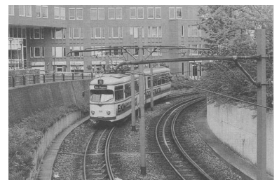
Ludwigshafen: Durch Tunnel in der Innenstadt wird die Straßenbahn in der zweiten Ebene geführt. (Foto: I. Köhler)
