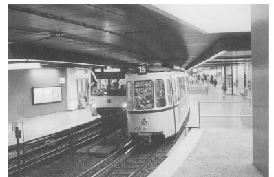
Stuttgart (Hbf.): Straßenbahntunnel mit Gleisen für zwei Spurweiten und hohen Bahnsteigen für Stadtbahnen sowie niedrigen für die Straßenbahn. (Foto: I. Köhler)
