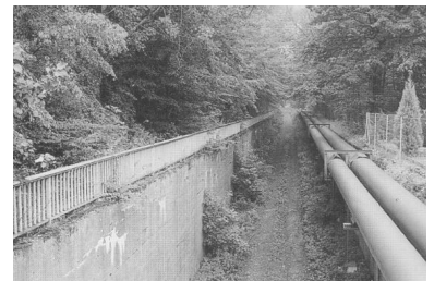
Nürnberg: Teile der ehemaligen Straßenbahntunnel können heute immerhin noch für Rohrleitungen genutzt werden... (Foto: I. Köhler)
