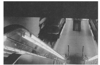
U-Bahn-Tunnel, Nürnberg. (Foto: I. Köhler)
