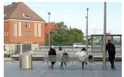
In der Halle fehlen Bänke, dafür gibt es welche ganz am Rand außerhalb der Halle (Foto: Marc Heller (August 2012))
