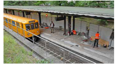
U-Bahnhof Thielplatz. Bahnsteigsanierung mit halbseitiger Sperrung in Fahrtrichtung Krumme Lanke. Leider dauern die Arbeiten doppelt so lange wie geplant. (Foto: Marc Heller)
