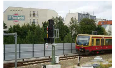
Hohe und niedrige Schallschutzwände: jetzt neu am Berliner Bahnhof Ostkreuz (Foto: Florian Müller)
