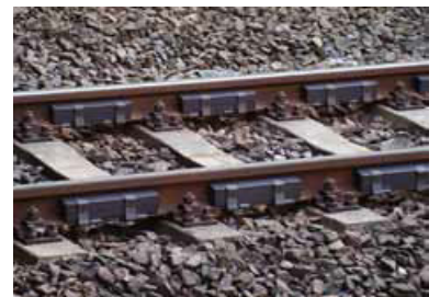
Schienenstegdämpfer im Einsatz auf der Berliner Ringbahn (Schönhauser Allee). Solche optisch unauffälligen Techniken sollte die Zukunft gehören. (Foto: Florian Müller)
