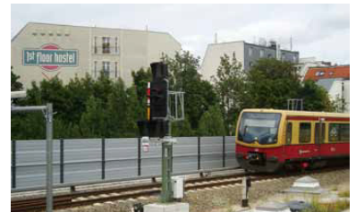
Hohe und niedrige Schallschutzwände: jetzt neu am Berliner Bahnhof Ostkreuz (Foto: Florian Müller)
