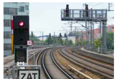
Freier Blick auf der Berliner Stadtbahn - dafür sorgt der Denkmalschutz. Schalldämmplatten in den Gleisen und regelmäßiges Schienenschleifen machen es möglich. (Foto: bahnrreisen-fotoarchiv)
