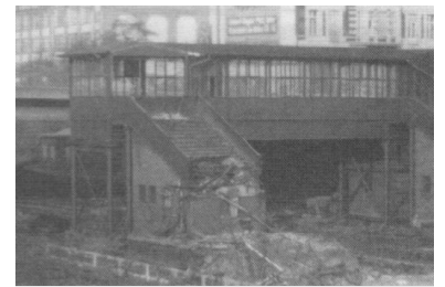
Erst renoviert, nun abgerissen: der Gewächshaus-Zugang am S-Bahnhof Westend. (Foto: H.-P.-Schwarz)
